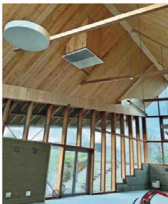
Intérieur en construction : bois, briques de terre crue, larges surfaces vitrées.
